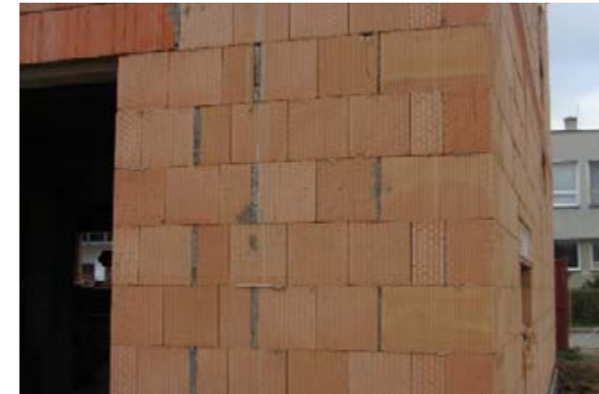
Správně provedená skladba ostění.
