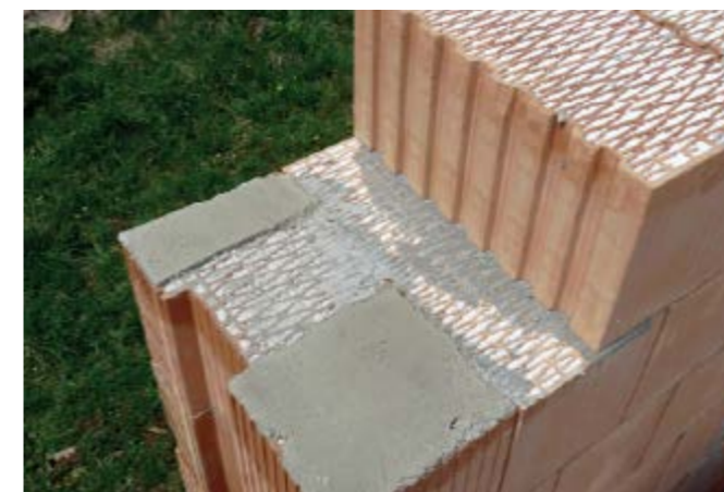
Správné podmaltování překladu před jeho osazením.
