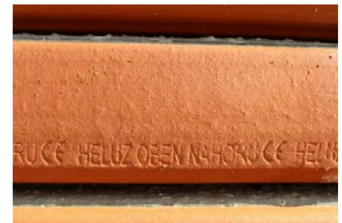
Tvar a označení vrchní části překladu.
